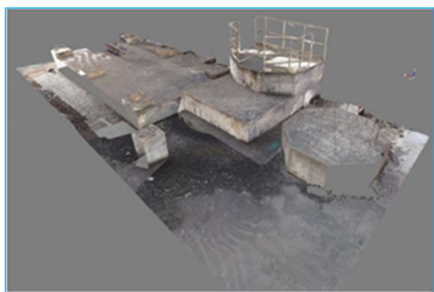
施工現場の3Dデータ
