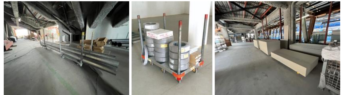
多種多様な荷姿：建設現場で動くAGVは未開発
